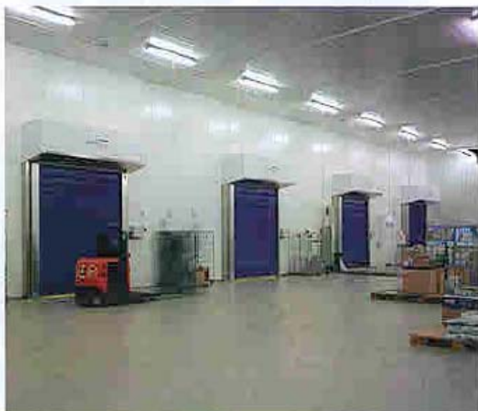
'Isolerede hurtigporte kan være med til at sænke energiomkostningerne på lageret. Imidlertid er det svært for mange lagervirksomheder at skaffe de økonomiske midler til nye porte, selv om energibesparelserne ville kunne finansiere anskaffelsen.
